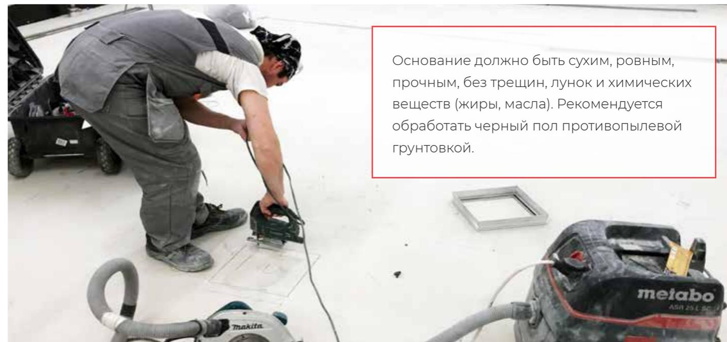
Основание должно быть сухим, ровным, прочным, без трещин, лунок и химических веществ (жиры, масла). Рекомендуется обработать черный пол противопылевой грунтовкой.
